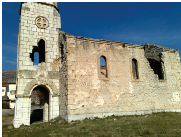
Zatečeno stanje objekta
