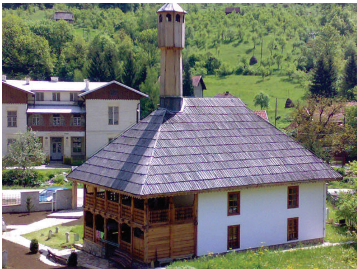
Sl.38. Džamija u Kraljevoj Sutjesci nakon radova rekonstrukcije krova, sofa, minareta i haremskog zida
