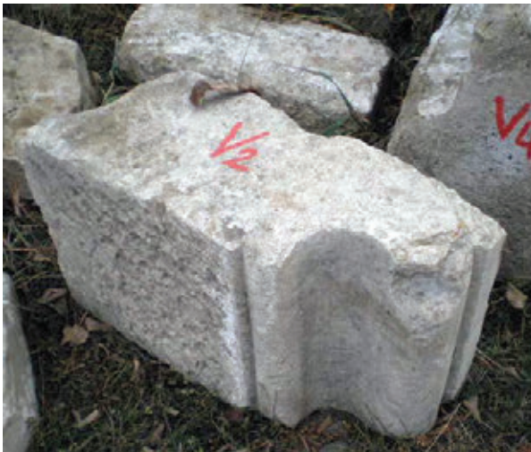
Sl.9. Fragment vijenac V2, vijenci su se nalazili na trijemu i glavnom kubusu ispod tambura i kupole i razlikuju se po visini te ih je zbog toga moguće ponovo ugraditi na istu poziciju (visinu).
