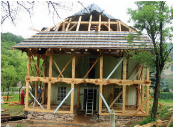
Sl.14. Konstrukcija vanjskih sofa i krova
