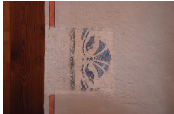
Sl. 24. Uz prozorski otvor konzerviran fragment na kojem se vidi presjek otkrivenih historijskih slojeva
