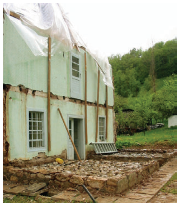
Sl.12. Demontirani zidovi vanjskih sofa
