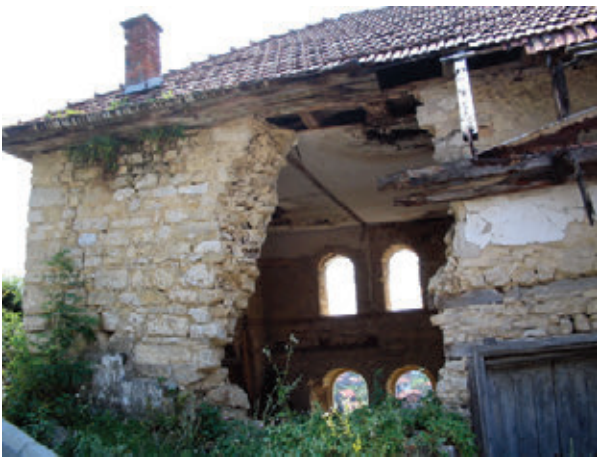
Sl.3. Dio ulazne (sjeverne) fasade 2005. godine
