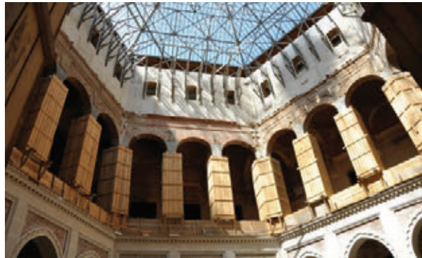
Unutrašnjost vijećnice u toku rekonstrukcije
