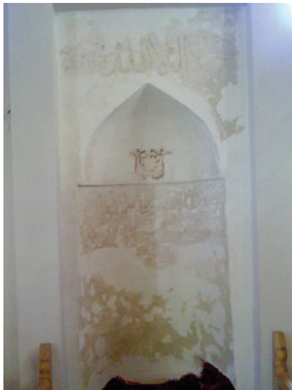
Sl.40. Izgled zatečenog stanja mihraba sa otvorenim sondama.
