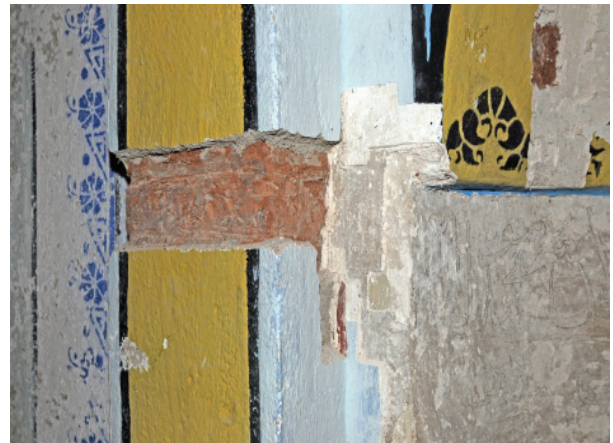
Sl.6. Praktičan tok istraživačko – otkrivačkih radova na zidnim površinama
