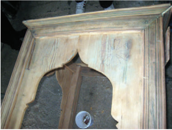
Sl. 32. U radionici očišćeni svi slojevi masne boje sa prednje strane mimbera
