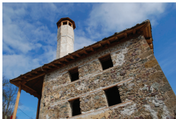
Izgled nakon radova
