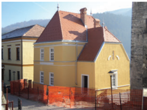
Nakon završenih radova
