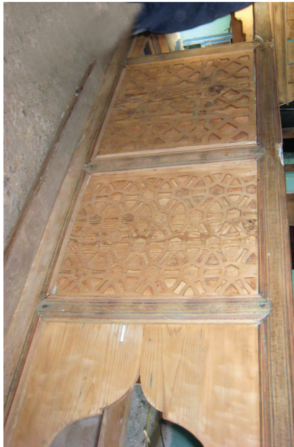
Sl.34. U radionici očišćeni svi slojevi masne boje sa bočne stranice mimbera
