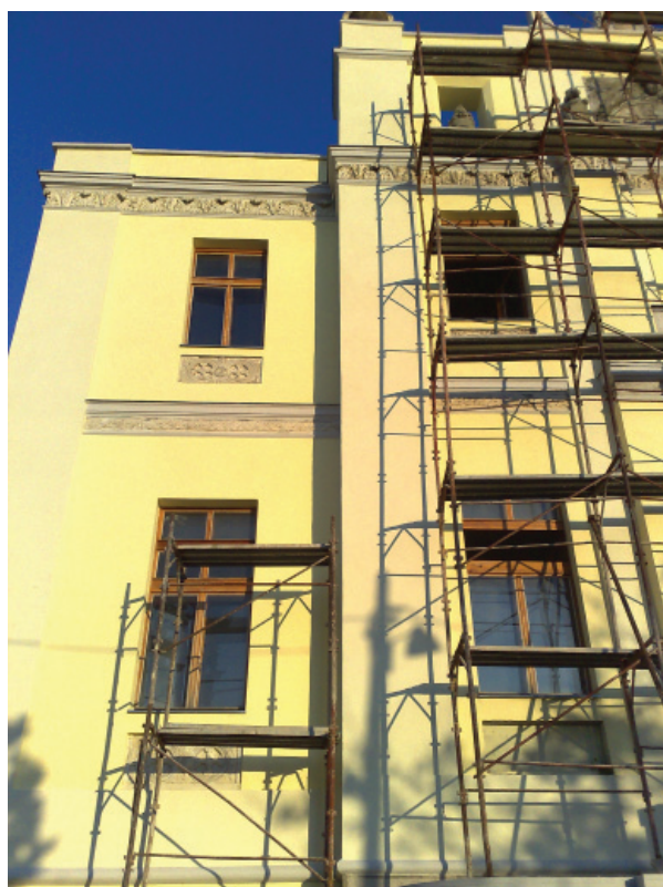
Radovi na fasadi nakon revitalizacije
