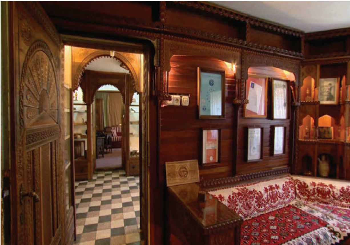
Sl.14. Sećija je na „L“ umetnuta u drveni okvir u kojem se nalaze bogato rezbarena vrata. Na naslonu sećije u materijalu su utkani floralni motivi. Gornji rub naslona sećije je završen drvenom lajsnom na koju je pričvršćena kruna. Lajsna je ukrašena urezbarenom tzv. bosanskom šarom – lanac rozeta u kvadratnim poljima. Ugao sećije nije ukrašen krunom već je ispunjen otvorenom rezbarenom vitrinom za knjige. U vizuelnom smislu, vitrina se po horizontali može podijeliti na tri dijela.
