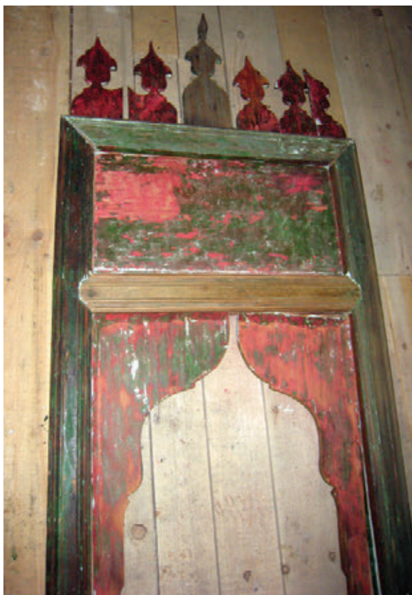
Sl.30. Ulaz u mimber prije intervencije
