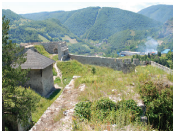
Bedemi nakon izvršenih radova
