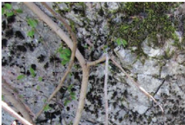
Sl. 4. Površina kamena prekrivena biološkim obraštajem
