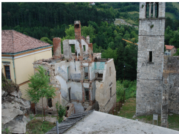
Objekat nakon raščišćavanja
