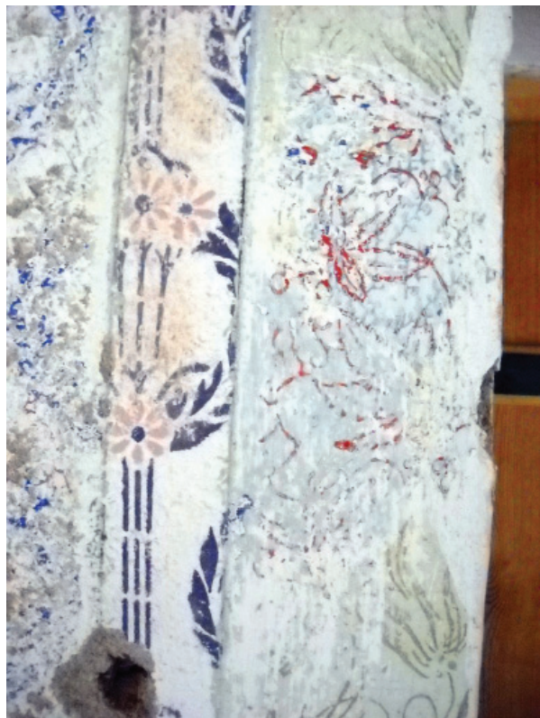
Sl.10. Presjek bojena slojeva radena valjcima i šablonima oko prozorskog otvora
