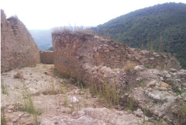
Stanje objekta prije intervencije
