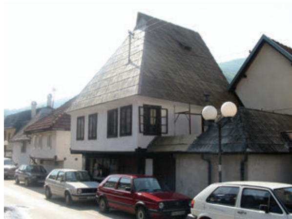
Porodična kuća Josipe Šakotić nakon rekonstrukcije
