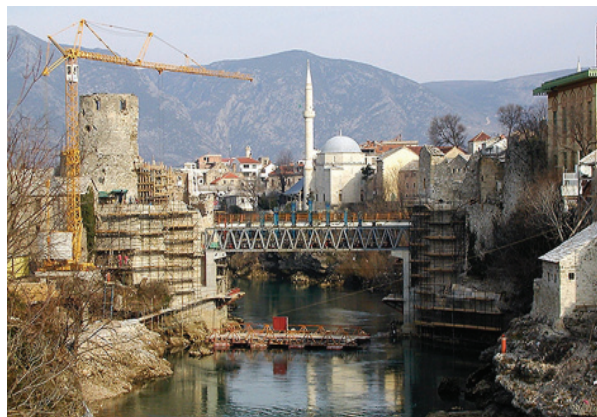
Stari most u toku rekonstrukcije
