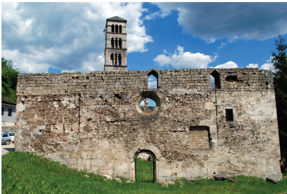
Zatečeno stanje objekta
