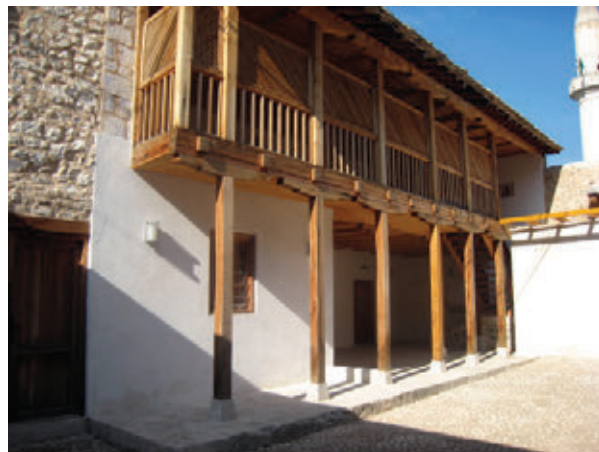
Šarića kuća nakon rekonstrukcije 2007. - 2013.
