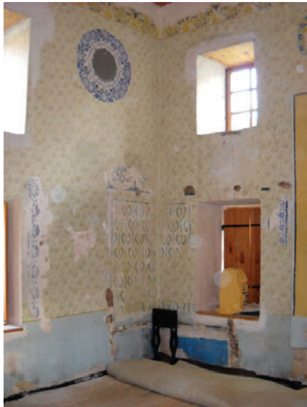
Sl.2. Početak istražnih radova na zidnim površinama
