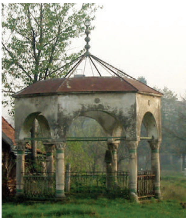
Stanje prije intervencije
