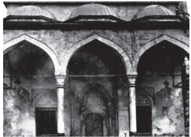
Sl.6. Lijevi mihrab u trijemu Aladže džamije u toku skidanja novih premaza dole očišćene površine
