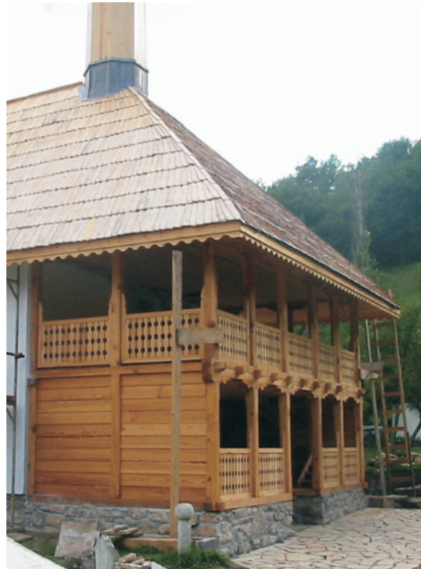
Sl.17. Drvene sofe nakon završenih radova
