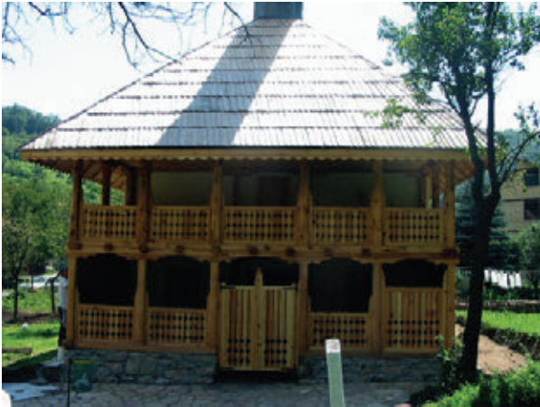
Sl.15. Prednja fasada nakon rekonstrukcije
