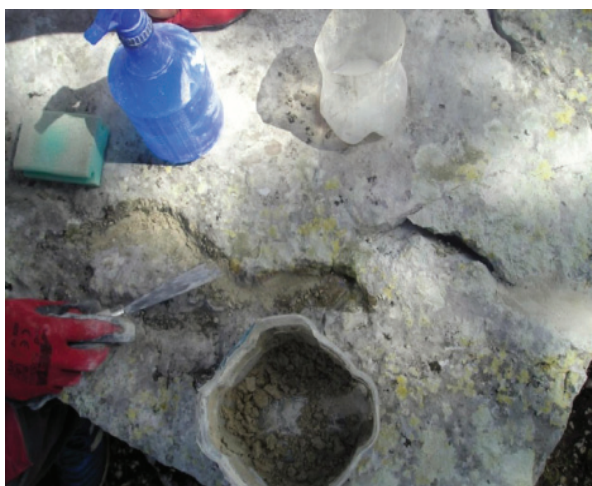
Sl. 13. Popunjavanje pukotina smjesom umjetnog kamena
