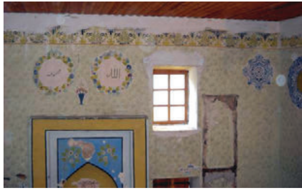
Sl.8. Završni horizontalni friz izveden šablonima
