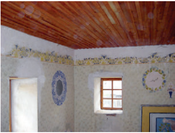
Sl.1. Početak istražnih radova na zidnim površinama i kaligrafskim zapisima
