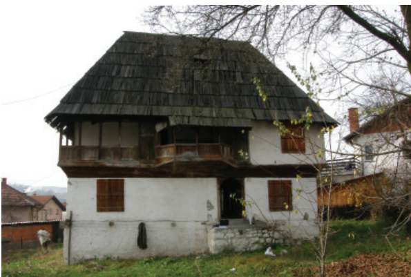
Zatečeno stanje kuće
