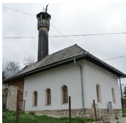
Okića džamija nakon rekonstrukcije
