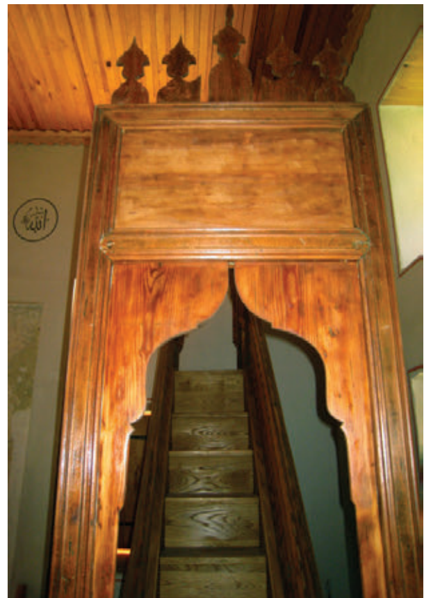
Sl.31. Ulaz u mimber poslije intervencije
