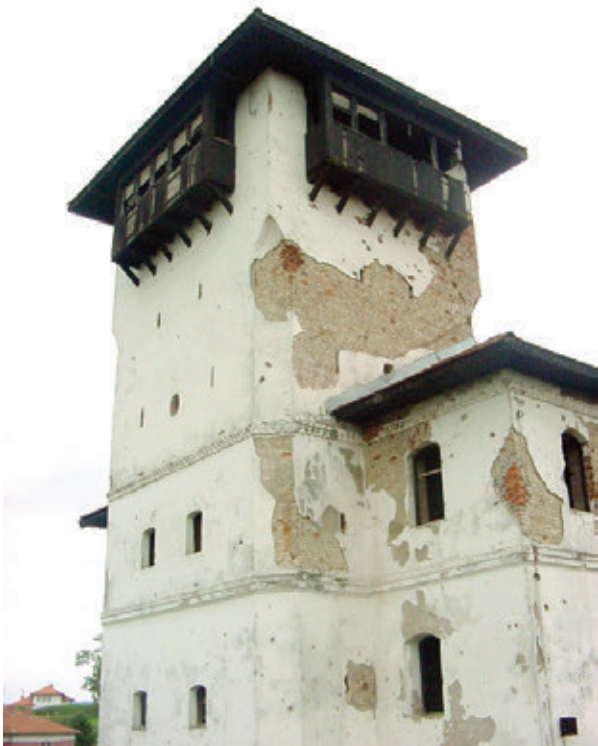
Stanje prije intervencije
