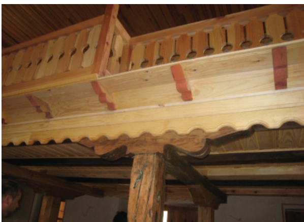
Sl.28. Stari i novi elementi na mahfilu
