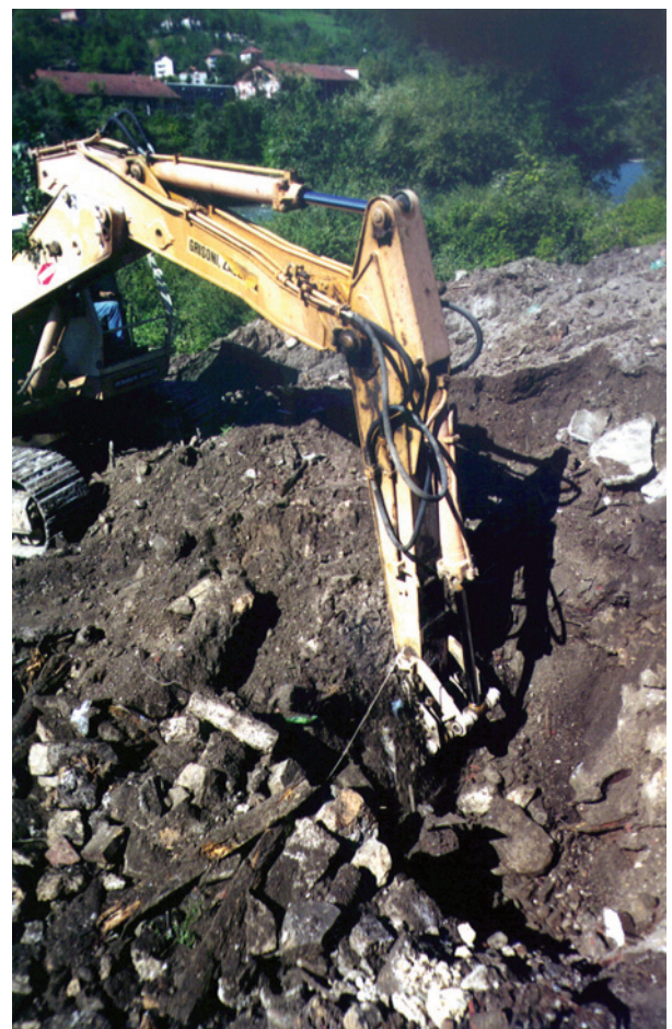
Sl.10. Mašinsko iskopavanje pronađenih ostataka Aladža džamije iz korita rijeke Drine
