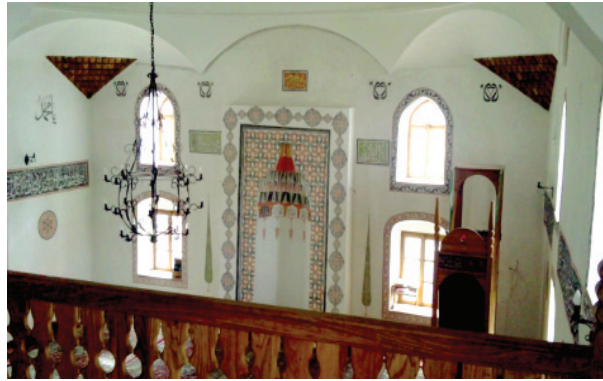
Sl.15. Prednji zid nakon restauracije
