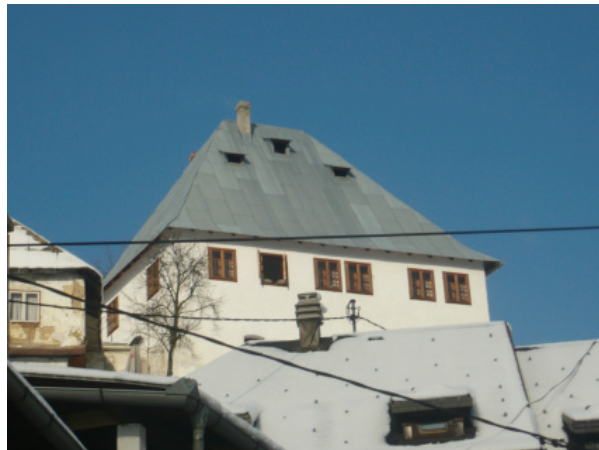
Izgled nakon radova
