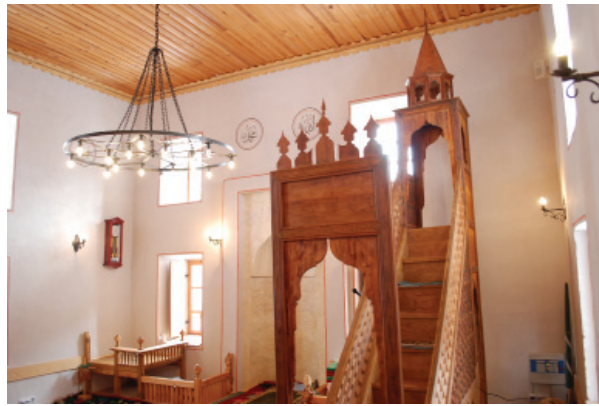
Sl. 28. Izgled čursa nakon čišćenja i ugradnje nedostatnih elemenata. Završno zaštićen mat lakom.
