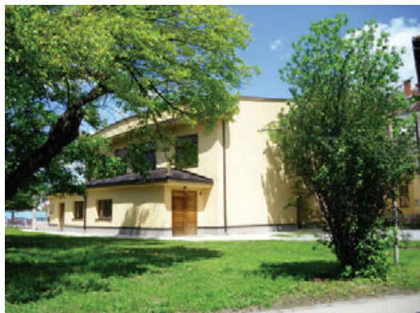
Muzej nakon završene rekonstrukcije
