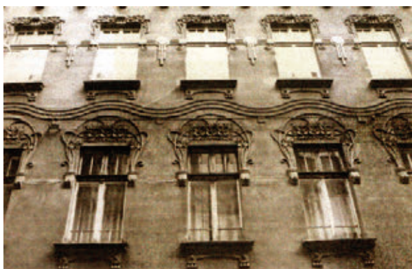
Sl.8. Izgled pročelja 1980. godine
