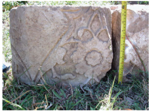
Sl. 5. Blok minareta sa izvanredno rafiniranom dekoracijom koji je sadržavao informacije o debljini stijenke vertikalne strukture.
