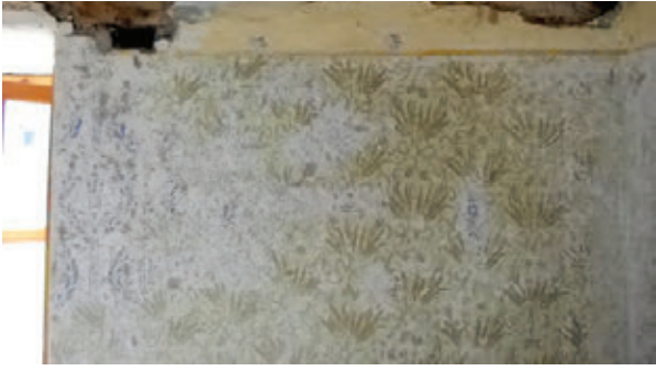
Sl.15. Ostaci maltera ispod tavanice iz osmanskog perioda (u podlozi kao nosač čerpić)
