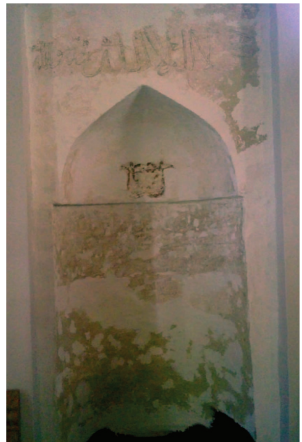
Sl.23. Mihrab nakon primjenjenih konzervatorskih mjera spreman za postupak retuša
