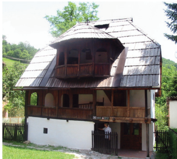
Porodična kuća Ive Duspere nakon rekonstrukcije
