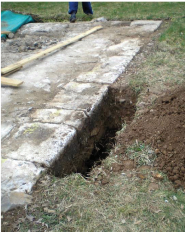
Sl.3. Izgled temelja sa istražnim iskopom koji je pokazao da se fino klesani blokovi nalaze na dubini do 30 cm, a ispod njih je sloj nepravilo lomljenog kamena.
