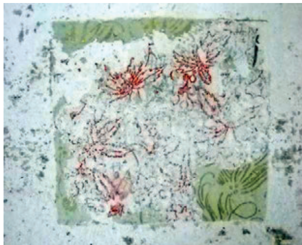
Sl.9. Presjek bojena slojeva novijeg datuma (slojevi izvođeni valjcima)
