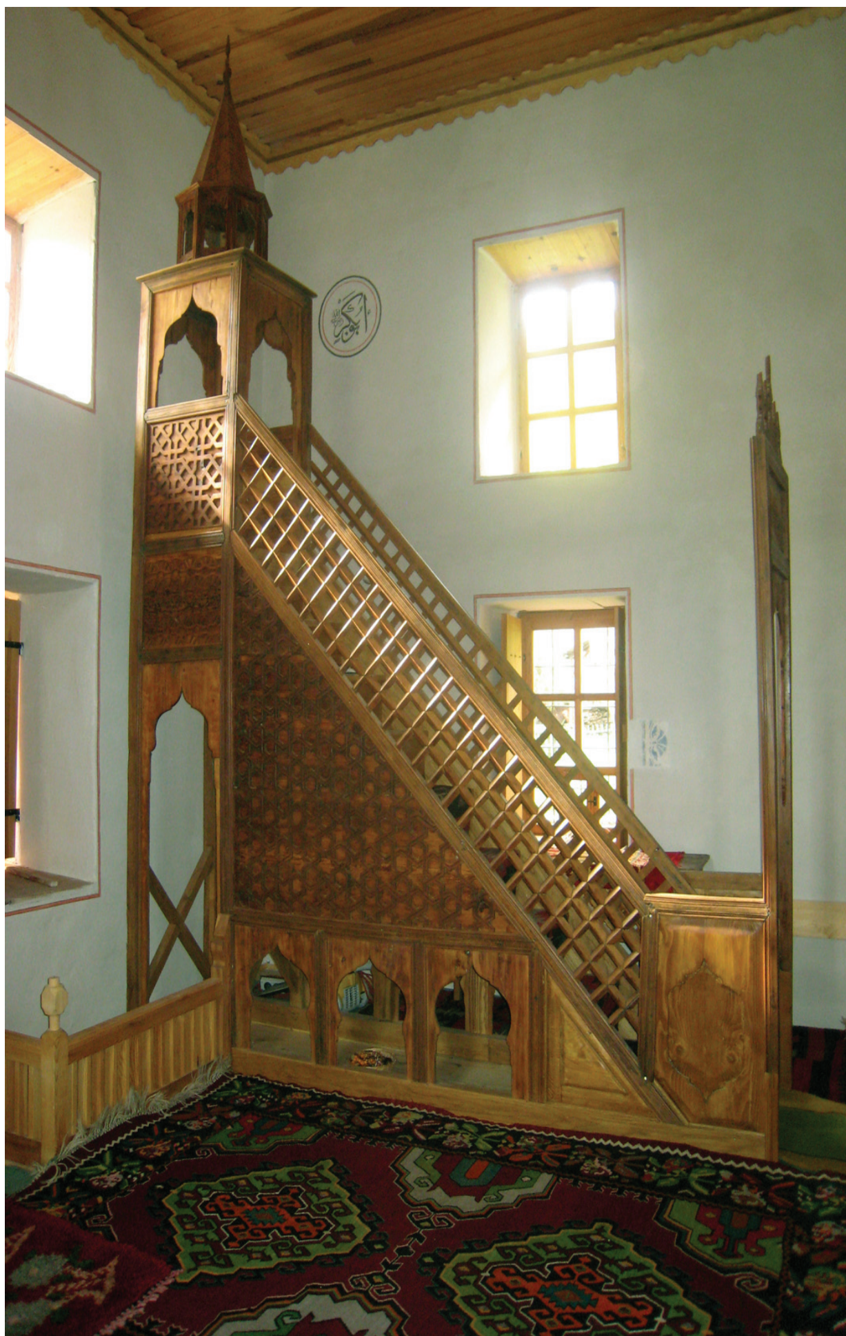
Sl.35. Mimber nakon sprovedenih čišćenja, šmirglanja, utezanja i ugradnje nedostatnih dijelova
