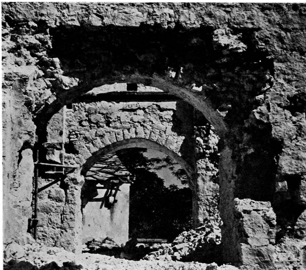
Sl. 10. Pogled na oltarski prostor iz dakonikona poslije demontaže bočnih paraklisa (snimio Z. Kajmaković)
