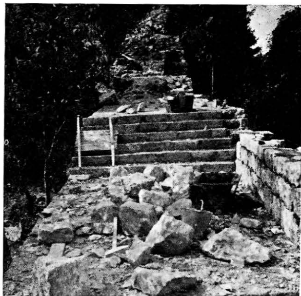
Sl. 3 Zid između Velike tabije i Kule na Džikovcu u toku konzervacije. Stariji zid jasno se očitava u odnosu na kasnije proširenje.
