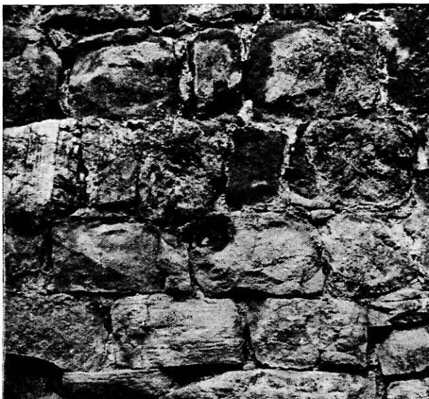
Sl. 2 Karakteristični primjeri zidanja na utvrdama Jajca — XV vijek.
