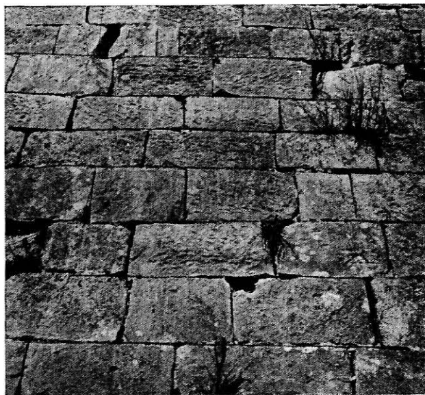
Sl. 3 Karakteristični primjeri zidanja na utvrdama Jajca — XVII vijek.
