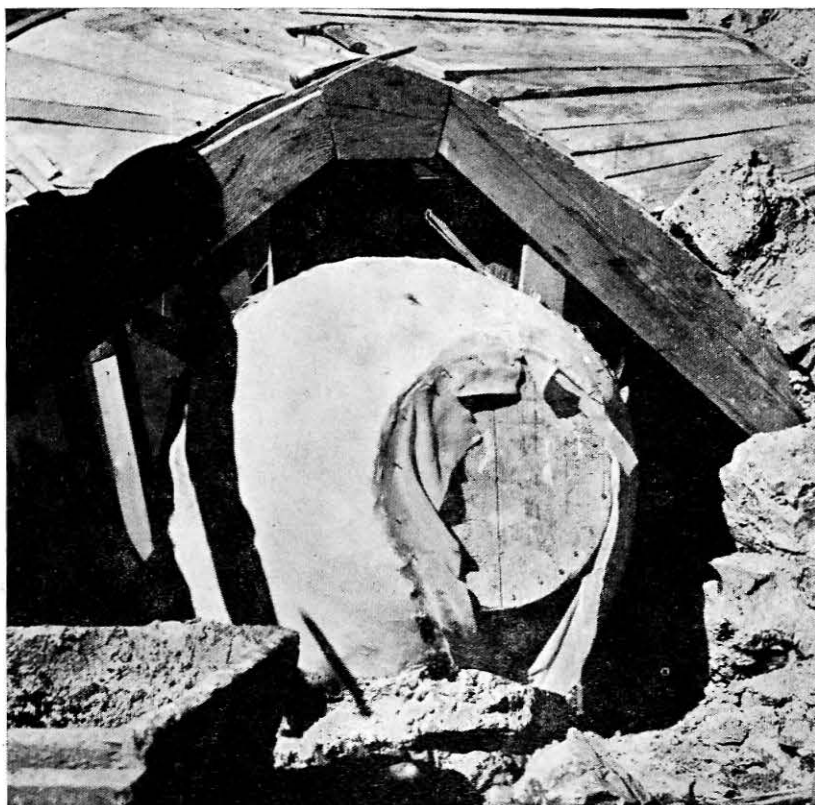
Sl. 15 Uzidavanje okulusa ispod krstastog svoda. (Snimio Z. Kajmaković)
