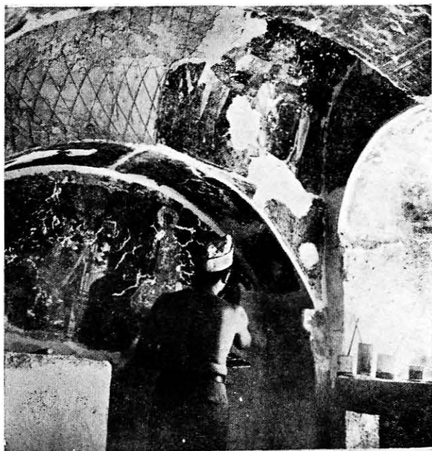
Sl. 20 Protezis u toku vraćanja fresaka. Uporediti sa sl. 19. (snimio Z. Kajmaković)
