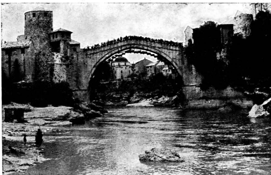
Sl. 1 Stari most sa skelom za pregled stanja svoda
