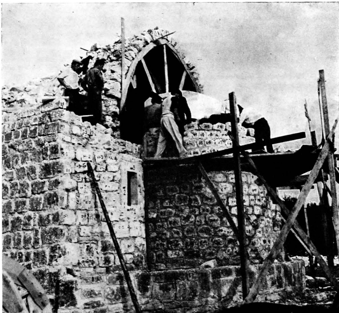
Sl. 14. Kompozicija Oranta postavljena je sa kalupom na svoje mjesto te je vraćena uzidavanjem u toku rekonstrukcije polukalote (snimio Z. Kajmaković)
