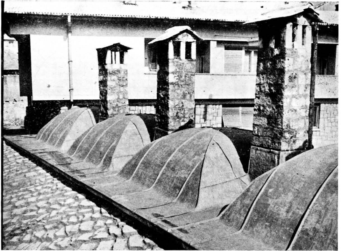
Slika 7. Izgled dimnjaka i spoljnih svodnih površina posle konzervacije i restauracije
