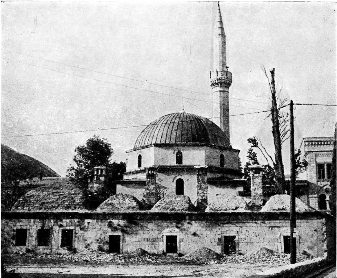
Slika 4. Izgled medrese tokom radova konzervacije i restauracije
