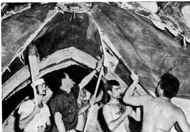
Sl. 4. Odvajanje freske »Hristos starac dana« u krstastom svodu (snimio Ćiro Rajić)
