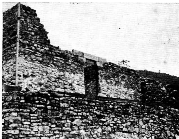
Sl. 5 Grobna kapela u toku rekonstrukcije 1968. godine (fasada)
