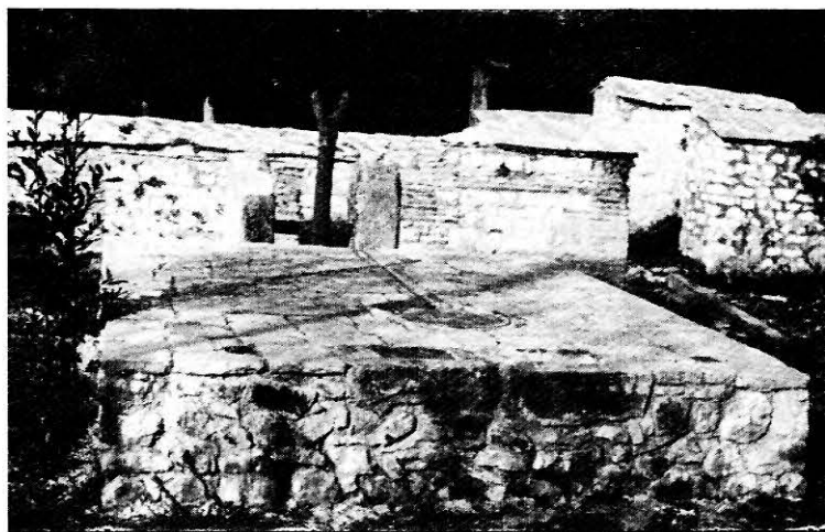
Sl. 11 Rekonstruirani forum torkulara sa arejom i kanalom za oticanje ulja.
