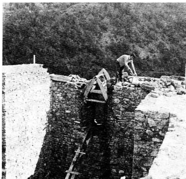
Sl. 6 Grobna kapela u toku rekonstrukcije 1968. godine (apsida)
