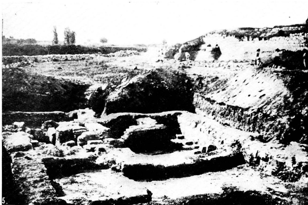
Sl. 17 Zgrada sa hipokaustom ispod južnog perimetra na Mogorjelu, sada zatrpana (iz dokumentacije dr Pat:cha).
