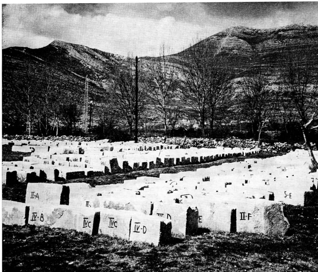
Demontirani kamni blokovi Arslanagića mosta (sl. 2)
