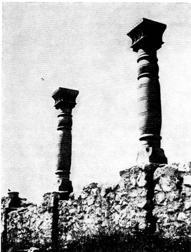
Dio restaurirane kolonade.
