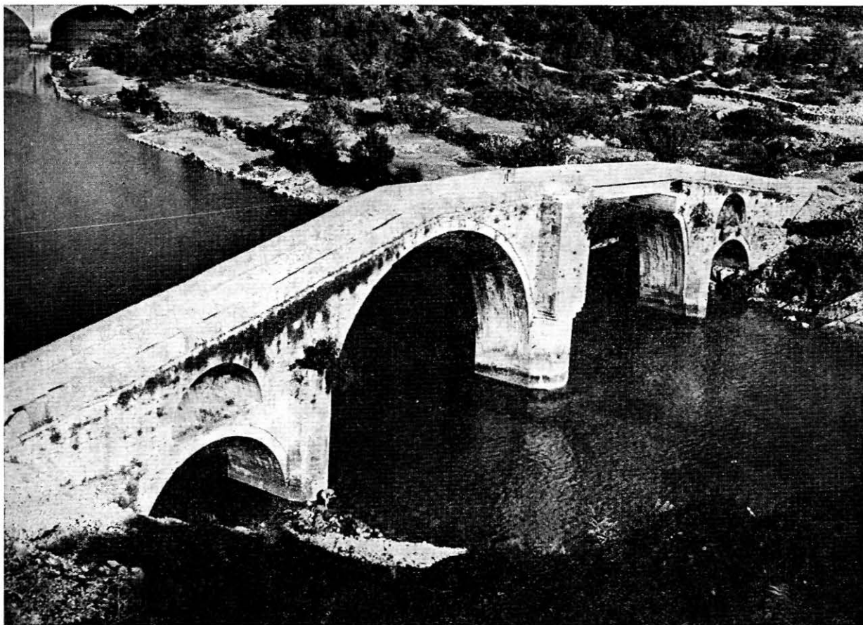
Arslanagića most prije demontaže (sl. 1)
