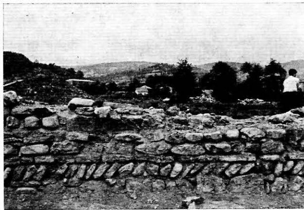
Dio otkopanog zida u tehnici »opus spicatum«; vidi se gnjezdasto ugrađena muljka koja se raspala.
