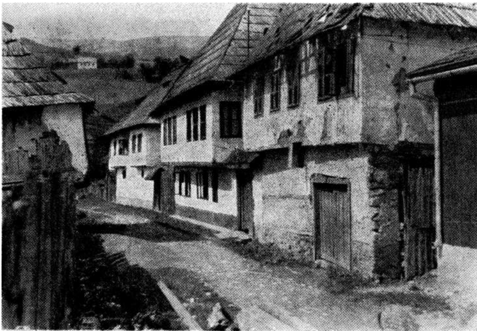
Ulica u starom Travniku. Ovi objekti u najskorije vrijeme treba da budu porušeni, da bi se na tom mjestu izgradila trokatnica
