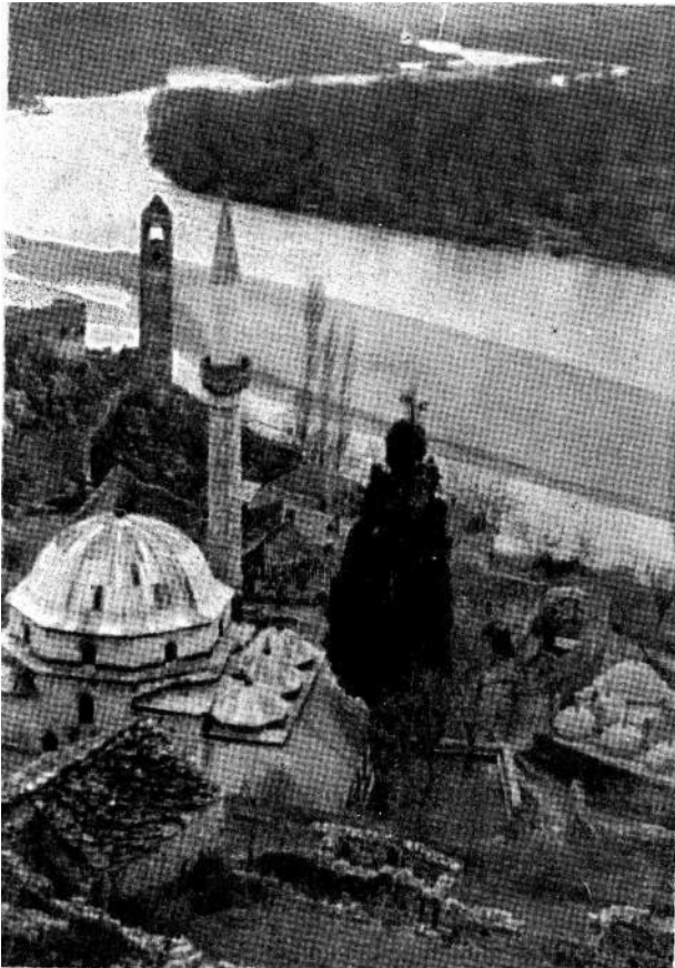
Počitelj — muzej arhitekture, gradić koji naglo umire. Već danas je oko dvije trećine kuća napušteno i bez krova.
