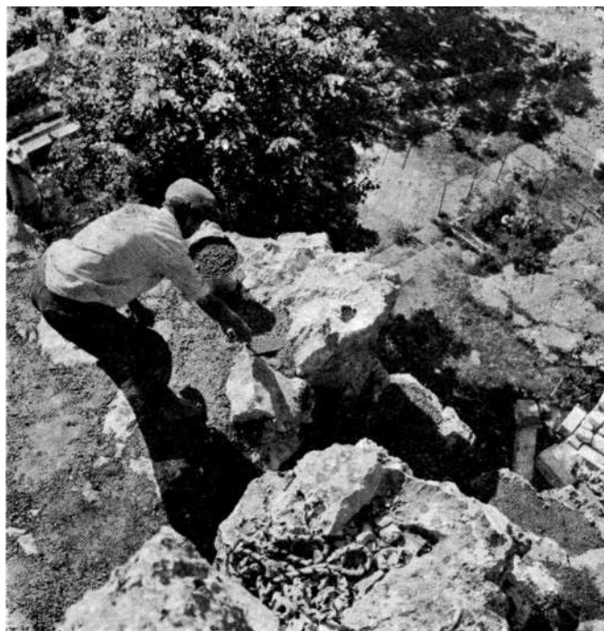
Sl. 18. Zatvaranje pukotina na steni nadnesenoj iznad crkve, čime je sprečeno direktno prodiranje vode u zidove objekta.
