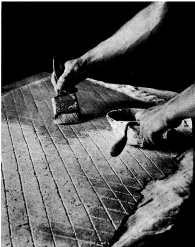
Sl. 15. Nanošenje lepljive paste na poledini odvojenog živopisa
