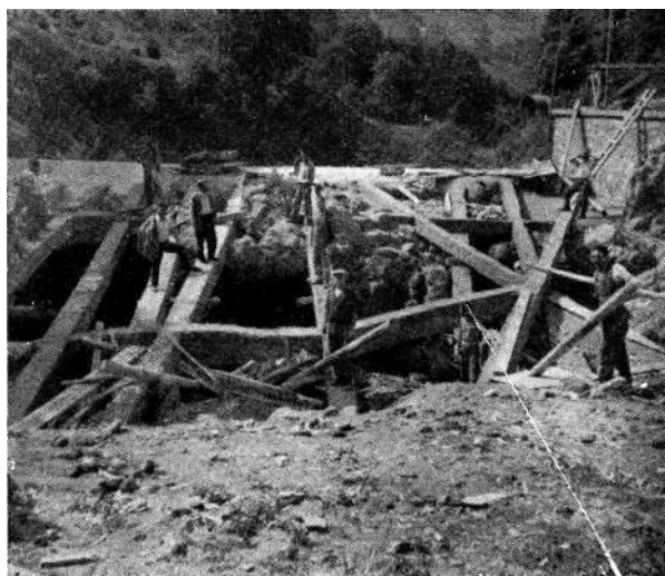
Sl. 11. Pogled na drugi do vodopada sa uzvodne strane i betonske grede preko rupe u kojima su ubetonirana čelična uža za ankerisanje.
